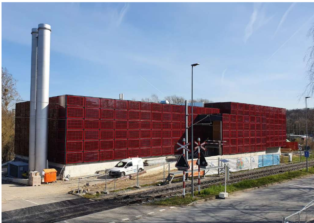
EPFL Heizzentrale: BYES GU / Helion Photovoltaik
